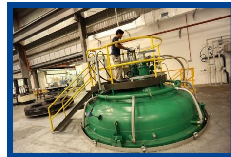
Freins carbone Inspection d'un four (Malaisie)
