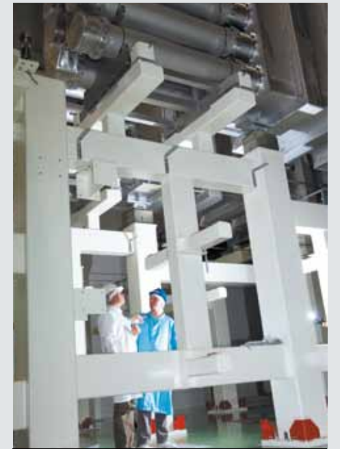
Supports des modules de pré-amplification du laser Megajoule du CEA, utilisé pour recréer les conditions de la fusion nucléaire. Sagem est impliqué dans ce programme.
