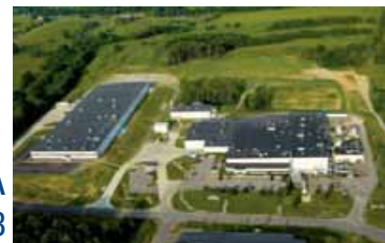
Usine Messier Bugatti Walton - USA Inauguration prévue en septembre 2008
